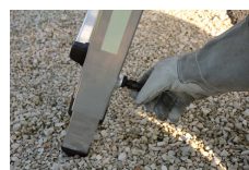
Kompensowanie poziomu za pomocą 4 przedłużeń bocznic
